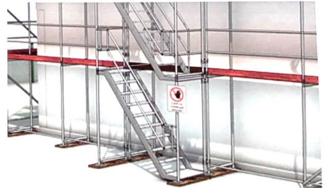
İskele, kurulum sonrasında kontrol edilir ve gerekli güvenlik işaretleri asılır.
