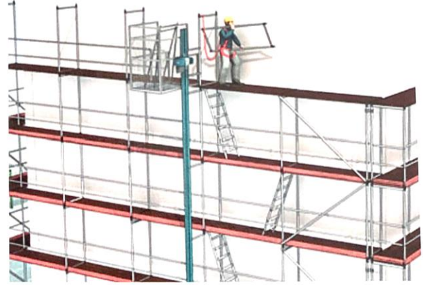
İskele bileşenleri uygun ekipmanlar kullanılarak üst katlara aktarılır.
